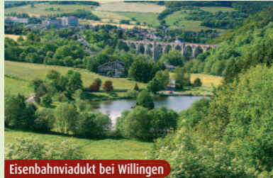
Eisenbahnviadukt bei Willingen
